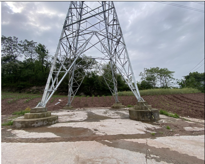
新建杆塔周围已复耕，塔基占地处原为道路用地，现已恢复硬化
